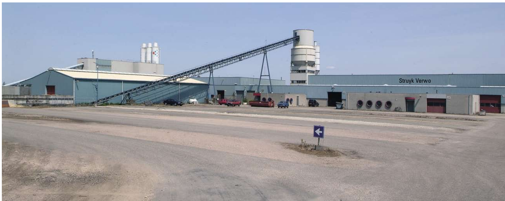
Vorbereiding nieuwbouw productielocatie SVA
